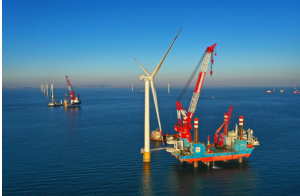
国新保理 2024 年受让的华能汕头勒门（二）海上风电项目风机安装工程施工现场
